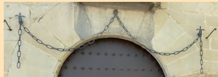
Cadenas que se pueden ver en la fachada del Palacio.
